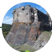
Le château de Muro
