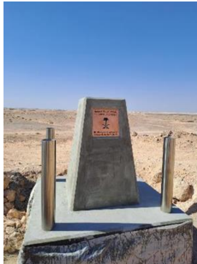
Construction d'une borne à la frontière Saoudo Jordanienne
