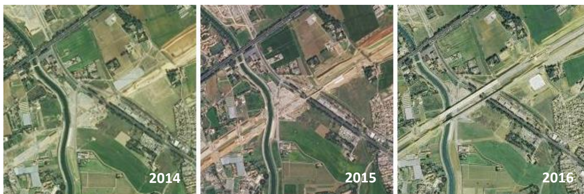
Déplacement de l'autoroute A9 autour de Montpellier (SPOT 2014-2015-2016) © IGN / Airbus Defence & Space
